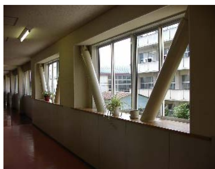
図-3 従来工法（左）と外部鉄骨ブレース工法（右）
