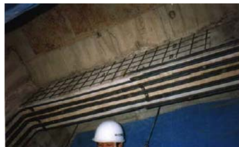
①補強筋取付
