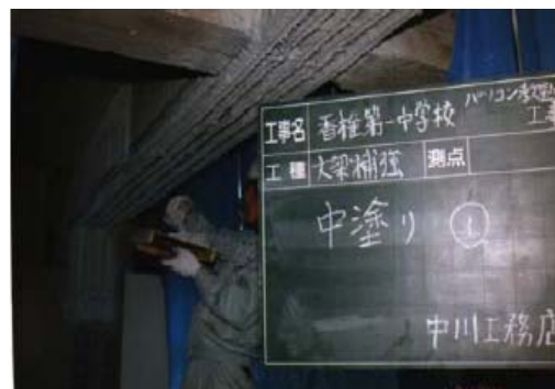
②特殊ポリマーセメントモルタルコテ塗り
