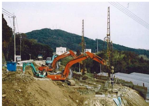
写真－３ 施工状況
