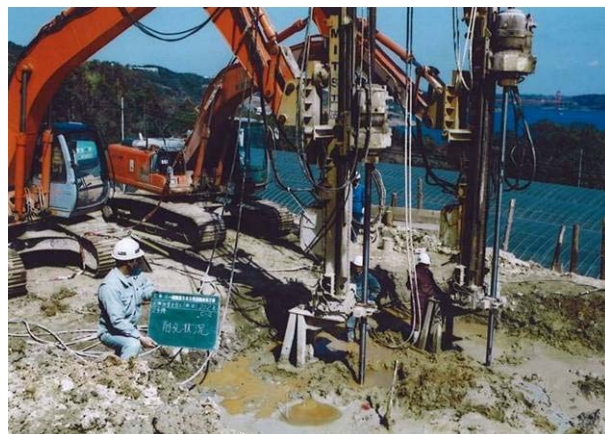
写真－４ 施工状況
