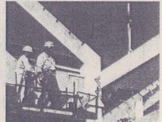
柱と梁のジョイントは種方にあわせて順に行う。
