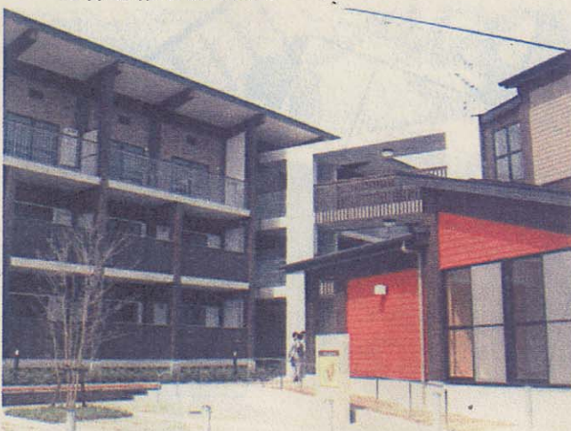
集会所（手前）と渡り廊下
