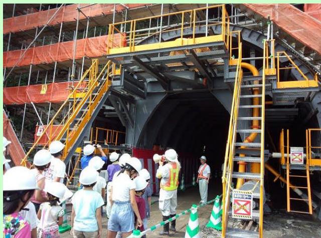
▲現場用ヘルメットを着用して、 設備を見学しながらトンネル内へ
