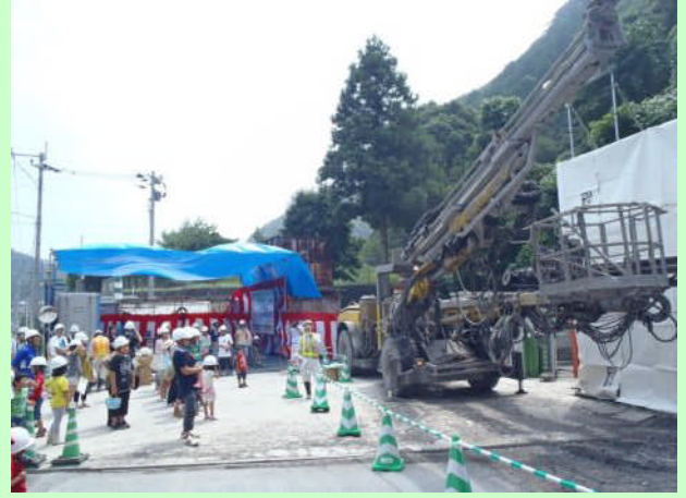
▲ドリルジャンボの操作実演状況を見学している様子
