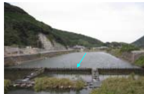
石木川合流点下流の改修状況 (山道橋上流)
