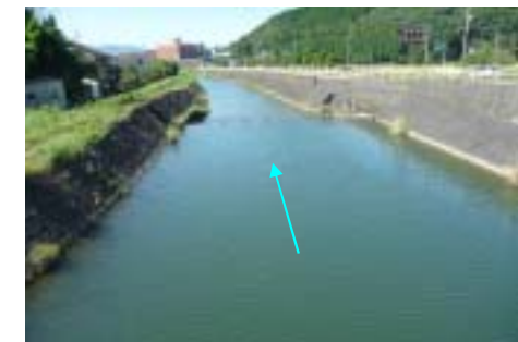
石木川合流点上流の改修状況 (横枕橋下流)
