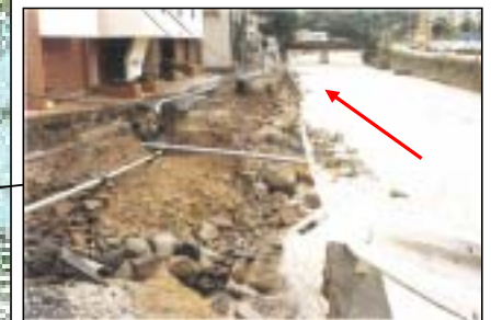
浦上橋上流(扇町)
