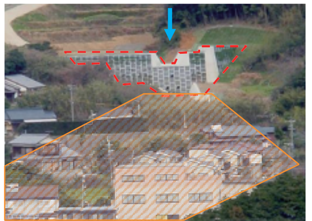
病院や人家を保全している砂防堰堤
