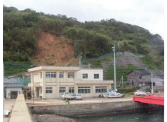
人家裏の斜面が崩壊(平成18年 五島市)
