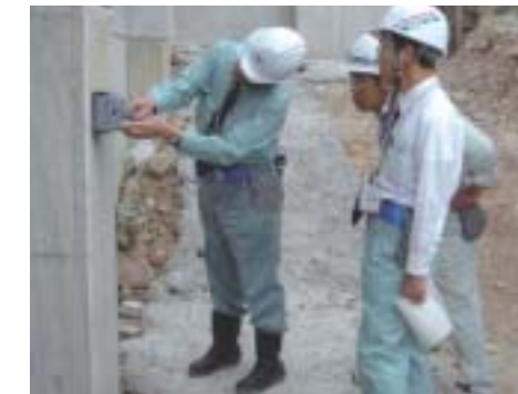
現場審査状況 RCレーダーで 鉄筋間隔、かぶり を調べています
