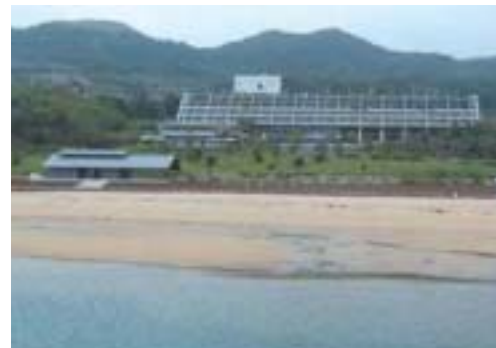
平成18年度一部供用開始した「川内港海岸」
