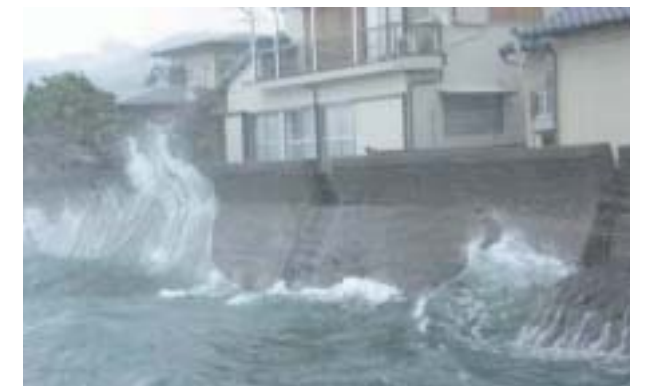
長崎港海岸 越波状況
