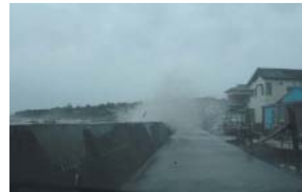
東高塩海岸 越波状況
