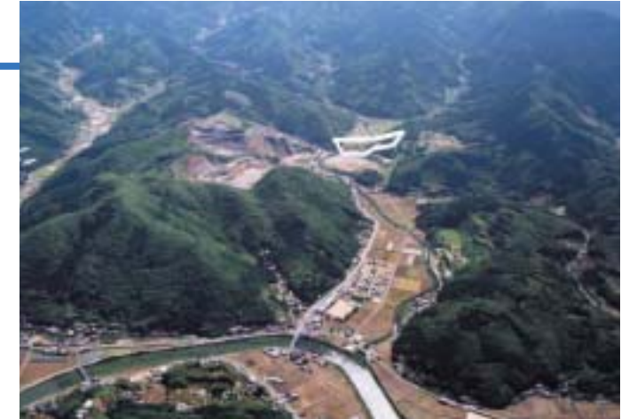
石木ダム建設予定地（川棚町）
