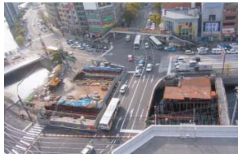
架替工事中の中央橋
