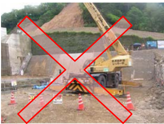
排ガス・低騒音機械確認写真
